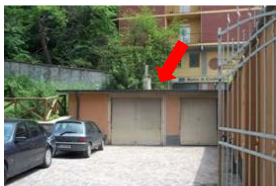
Centrale termica esistente a fianco al parcheggio
