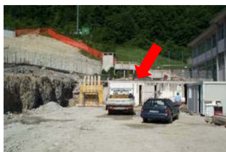
La localizzazione della centrale termica esistente.
