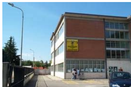
Vista dell'istituto scolastico dal lato della strada.
